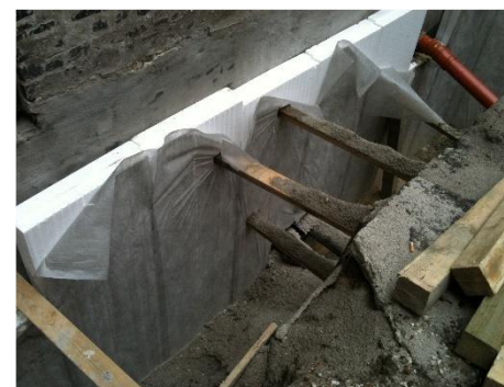
Eksempel på udvendig isolering af kælderydervægge
