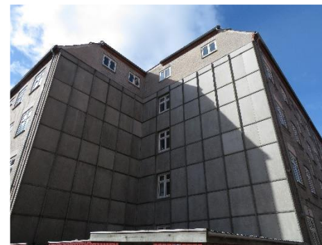
Gavle isoleret udvendigt
