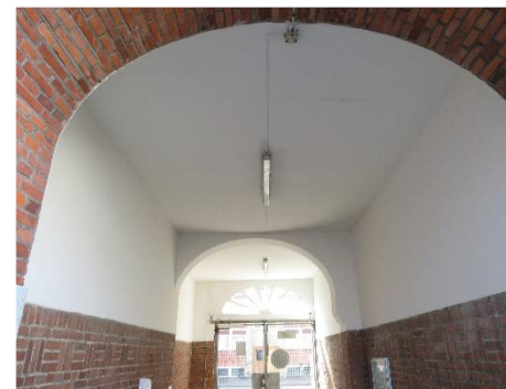
Portloft er isoleret
