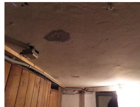
Loft i kælder med indblæst isolering
