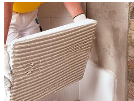
Fuldlimede isoleringsplader til indvendig efterisolering
