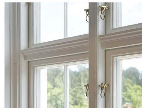
Koblet vindue set indefra
