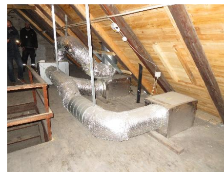
Ventilationsanlæg på loftet
