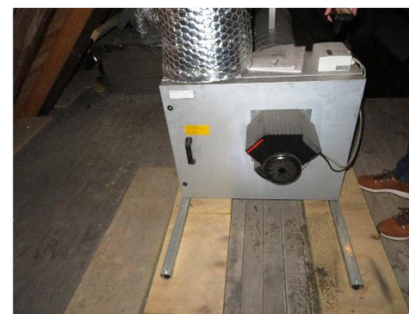
Udsugningsmotor på loftet
