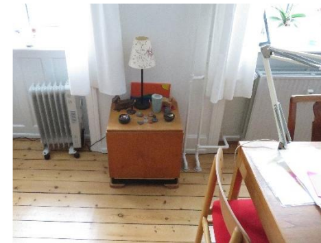
Radiator i lejlighed
