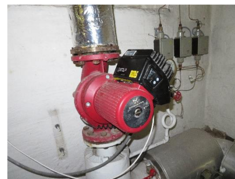
Cirkulationspumpe
